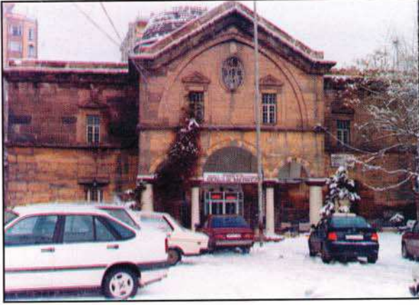
Resim 8 : Surp Asvazdzin Kilisesi, batı cephe
