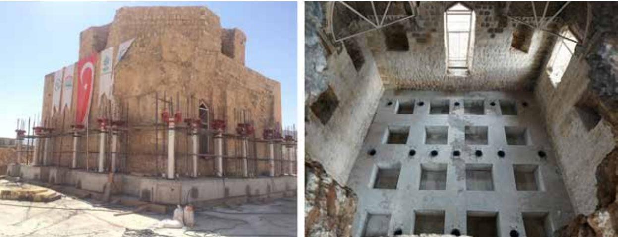
Resim 23: Hamamın Yeni Konumuna İndirilmesini Takiben Krikoların Sökülmesi Sonrası Görünüm (KVMGM Arşivi)
