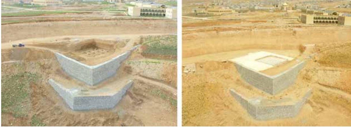
Resim 15: Yeni Konumunda Fore Kazık Üzeri Betonarme Temelin İnşası (KVMGM Arşivi).
