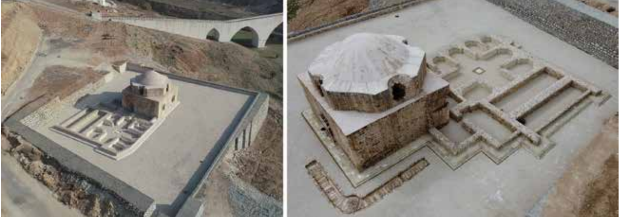
Resim 24: Hamamın Yeni Yerinde Montajı ve Aralık, Ilıklık, Sıcaklık, Külhan ve Sarnıcın Plan Düzleminde Sunumu (KVMGM Arşivi)
