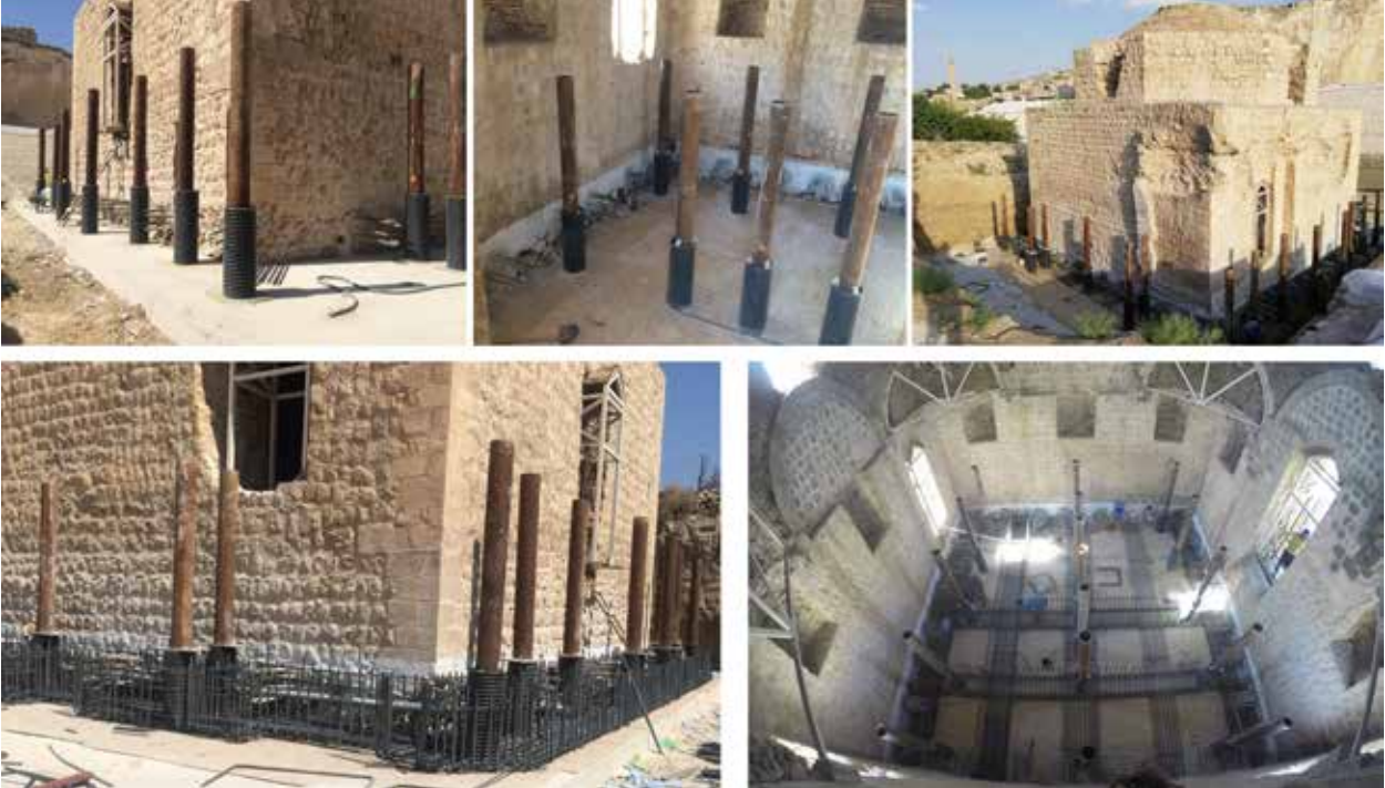
Resim 19: Hidrolik Krikoların Çelik Boruları, Ard Germe Taşıma Plağından Görünüm (KVMGM Arşivi).
