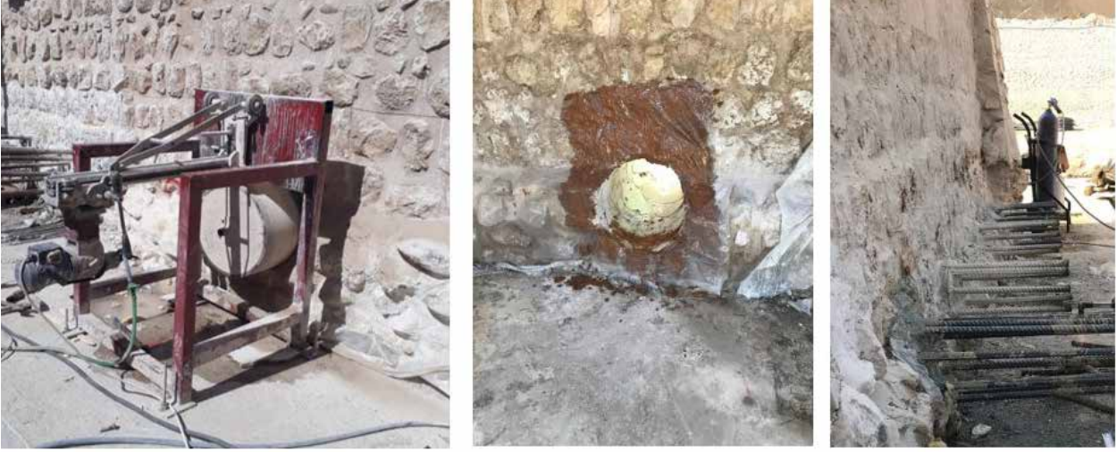
Resim 18: Beden Duvarlarına Entegre Edilecek Betonarme Grid Sistemi İçin Delik Açılması, Donatıların Yerleştirilmesi (KVMGM Arşivi).
