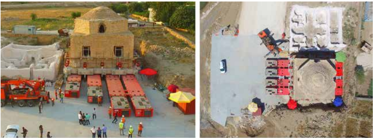
Resim 21: Betonarme Grid Sistemle Hamamın 150 Cm Kaldırılıp Araca Yüklenmesi (KVMGM Arşivi).
