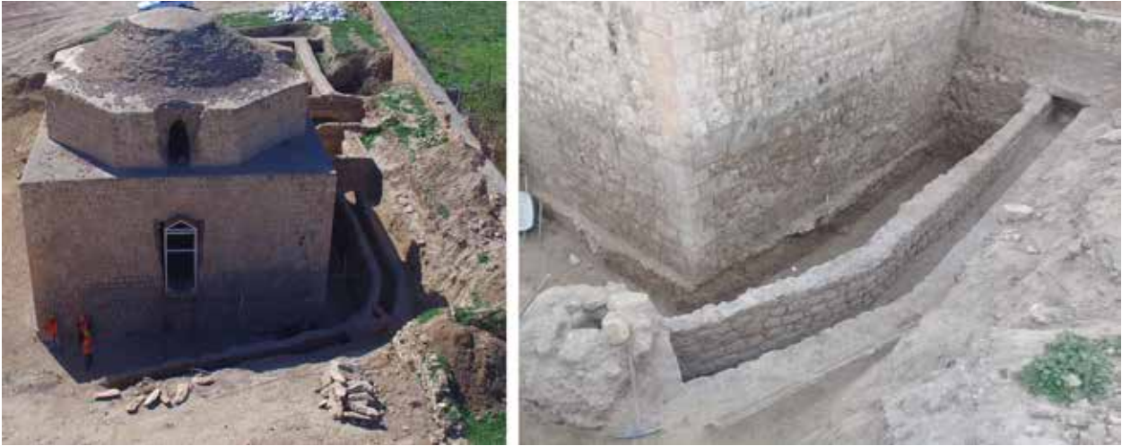
Resim 12: Atık Su Kanalı (KVMGM Arşivi).
