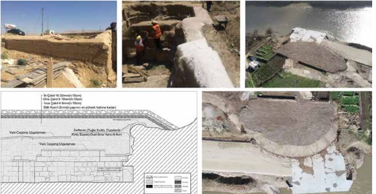
Resim 25: Aralık, Ilıklık, Sıcaklık, Külhan ve Sarnıcının Özgün Yerinde Koruma Uygulamaları (KVMGM Arşivi)
