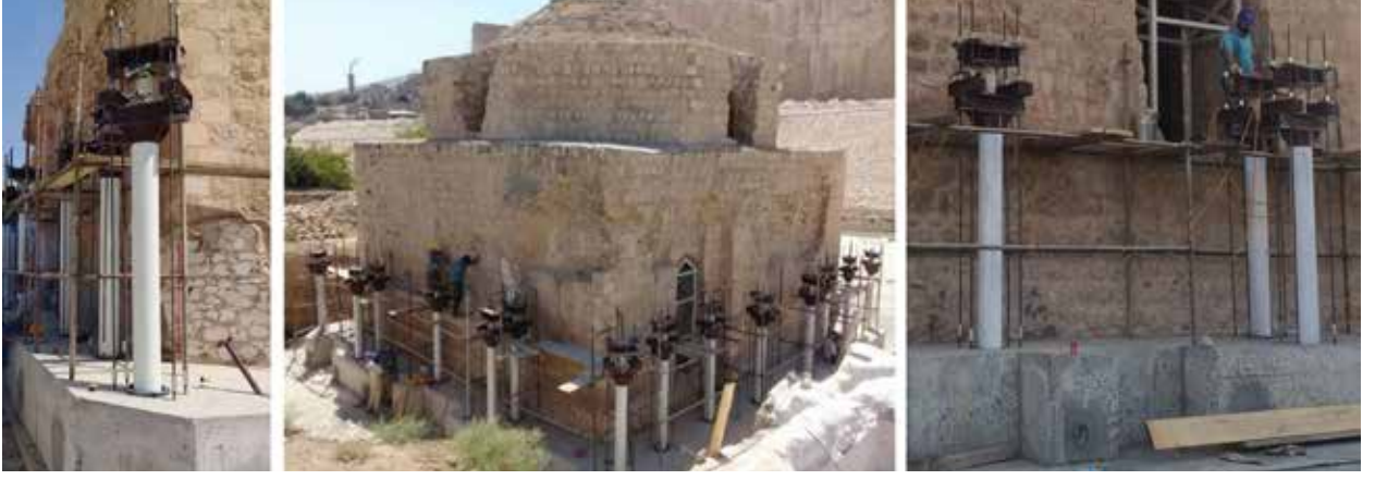
Resim 20: Betonarme Grid Sistem Kaldırma Plağının Donatıları Ve Krikoların Yerleştirileceği Çelik Borular (KVMGM Arşivi).
